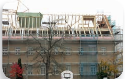
Der neue Dachaufbau des THSJ
