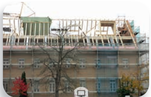
Der neue Dachaufbau des THSJ
